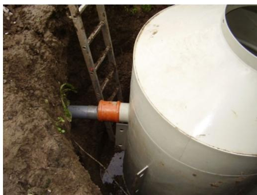
Crtež 1.6 – Ugradnja POV – nestabilna podloga
